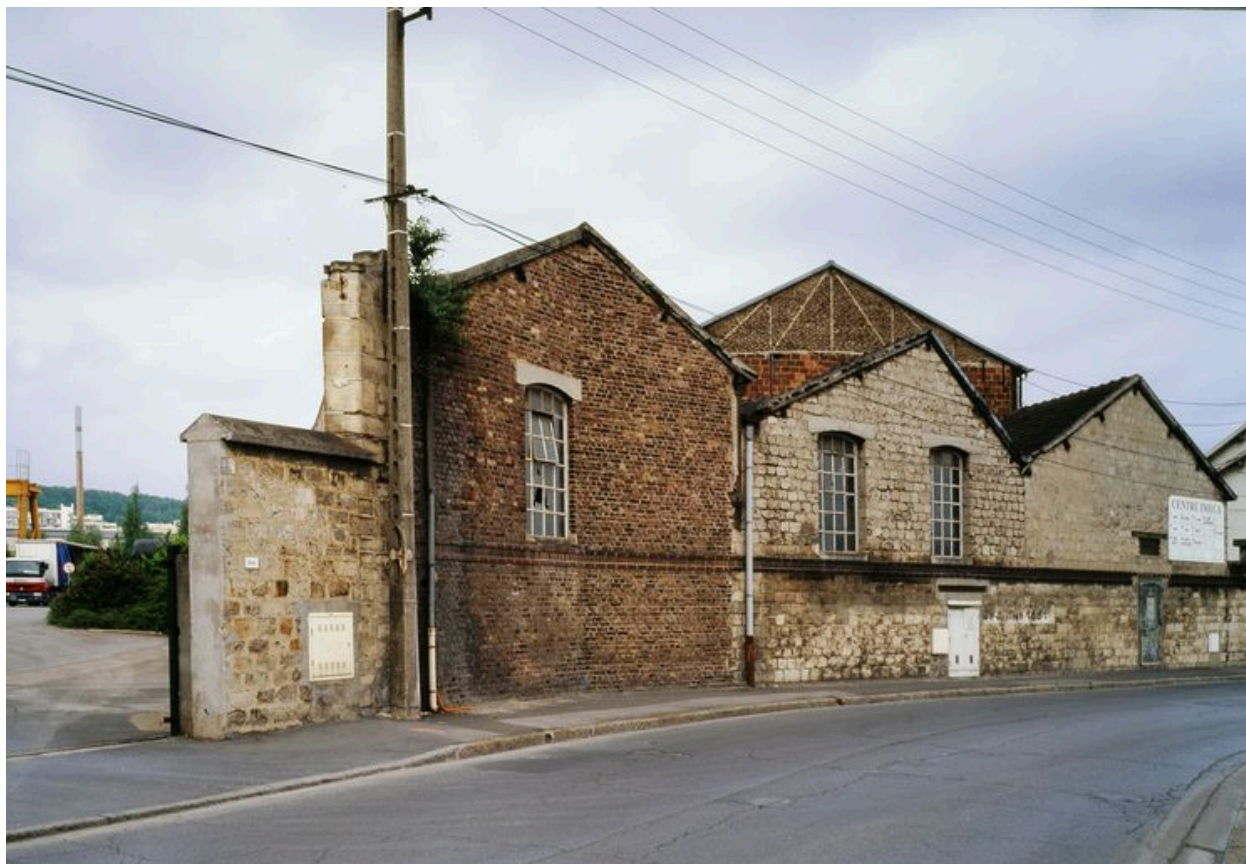
Façade des ateliers sur la rue des Usines.
