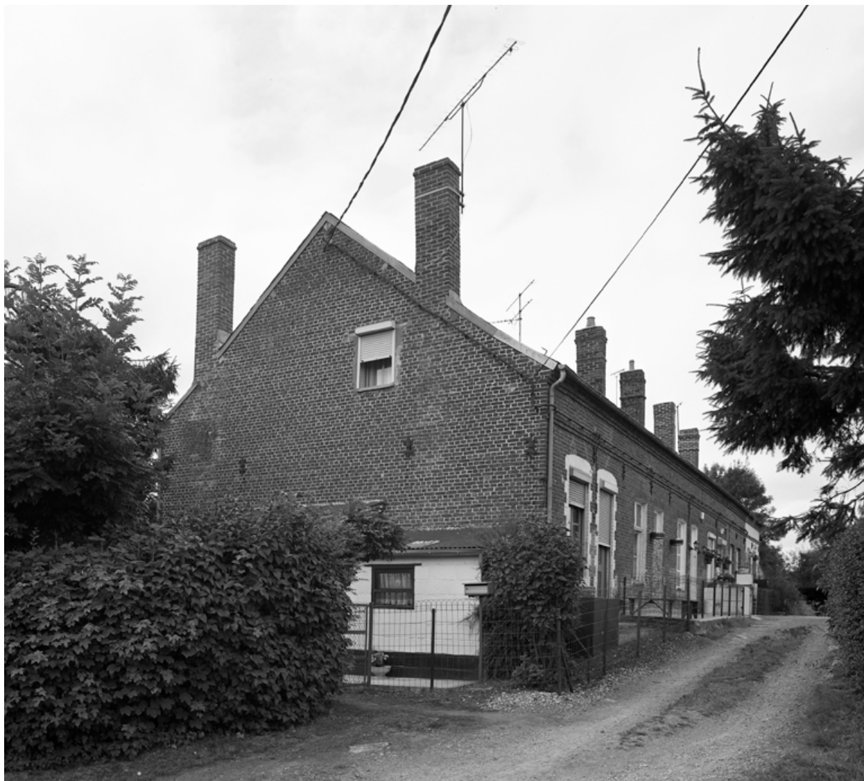
Vue des logements ouvriers qui composent la partie ouest de la cité construite pour les employés du tissage.
