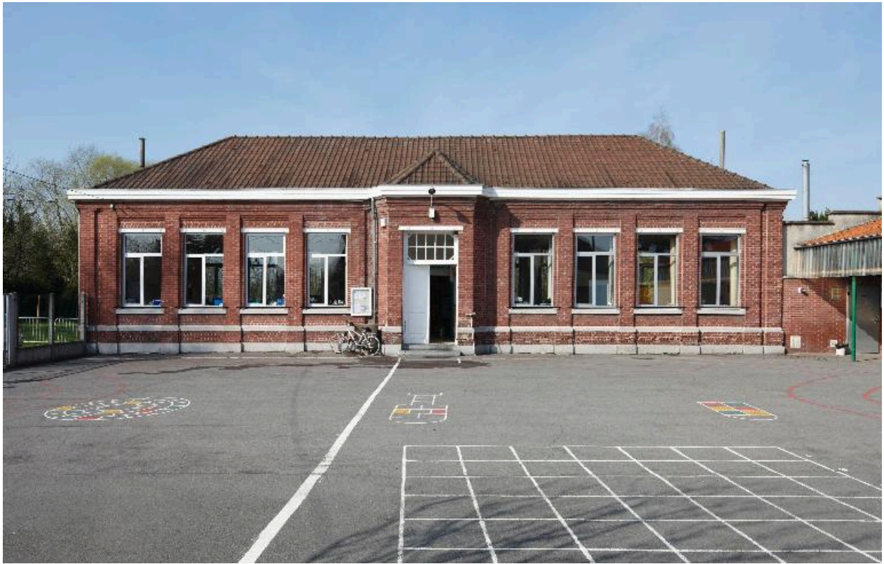
Vue générale d'une salle de classe et le préau.
