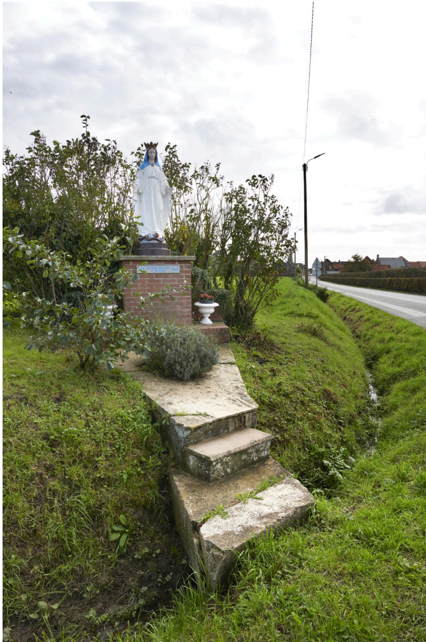
Détail de la structure générale de l'oratoire.
