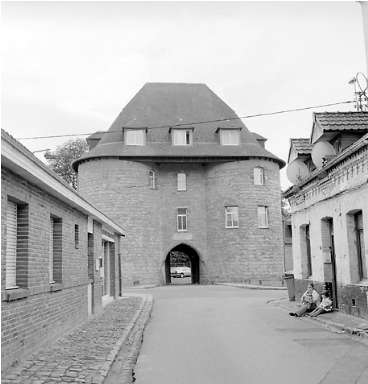
Ouvrage d'entrée, vue frontale dans l'axe de la rue Marcel-Maes (côté ville).
