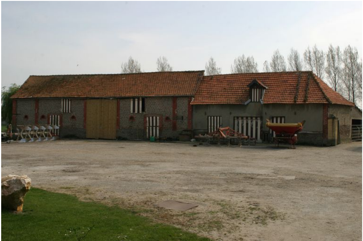
Vue de la grange et étables de 1910 placées au sud de la cour.
