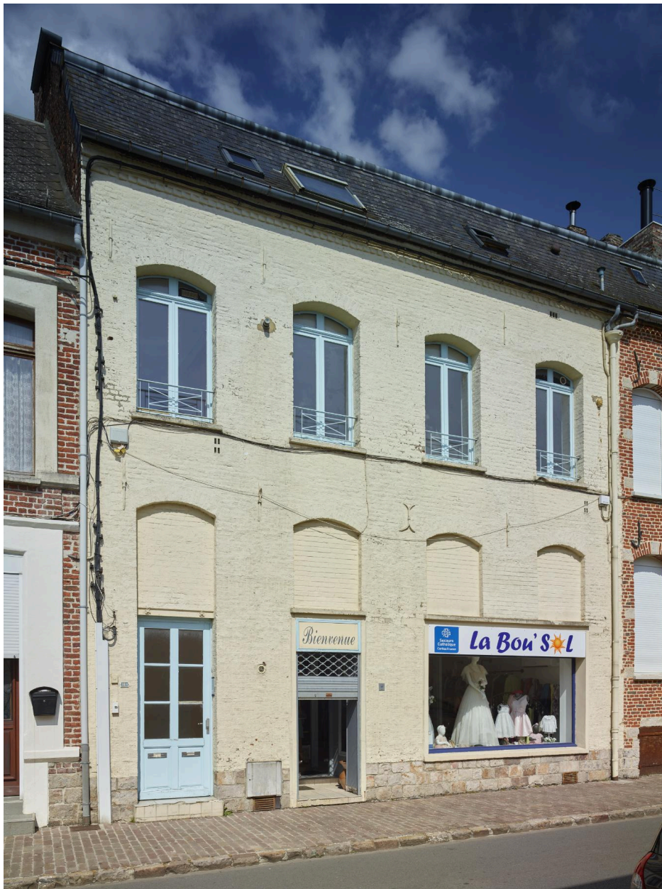
Ancienne école des Sœurs de Sainte-Thérèse d'Avesnes - 16-18, rue du Général-Bouttiaux : détail de la partie modifiée de la façade.
