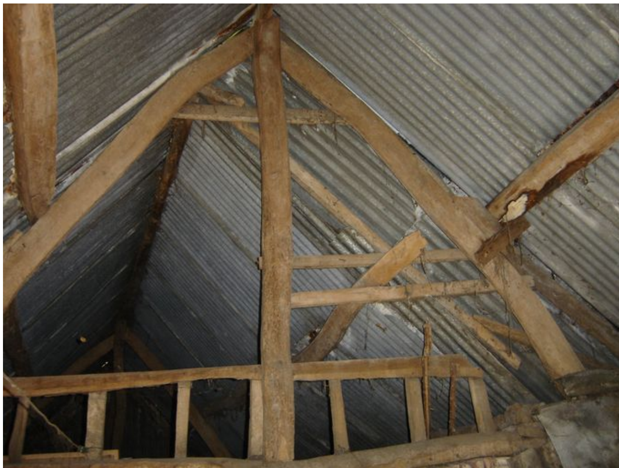
Vue détaillée de la charpente des dépendances.
