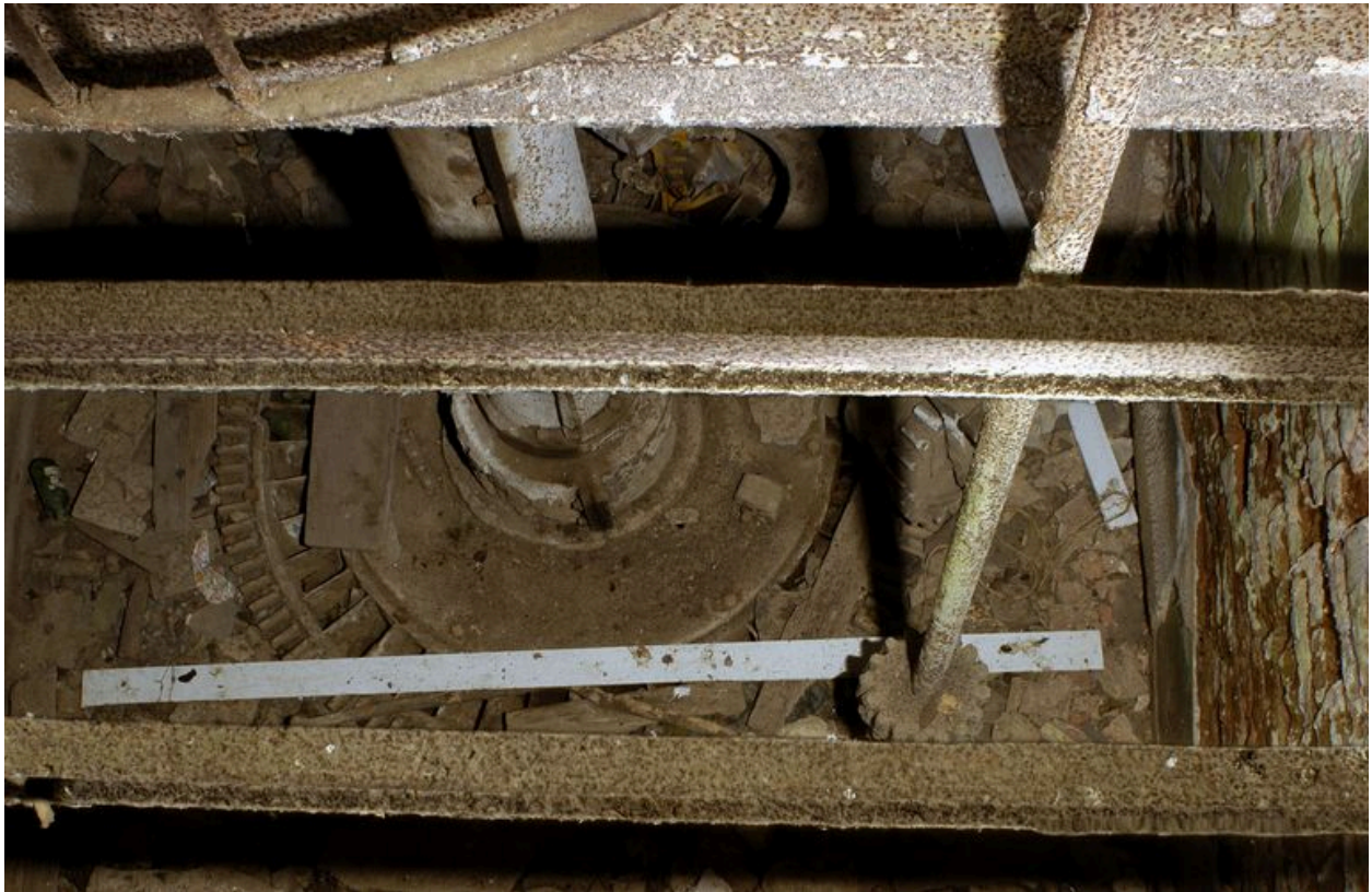
La partie supérieure de la turbine du moulin.
