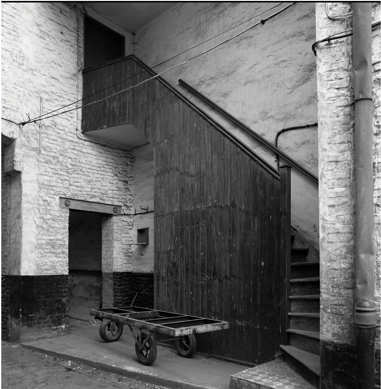
Escalier menant au logement patronal (cf. angle de prise de vue 3).
