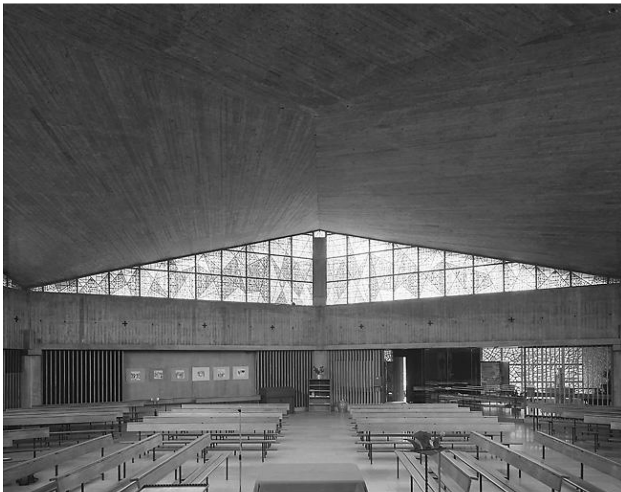
Verrières n° 4 et 5, vue d'ensemble.
