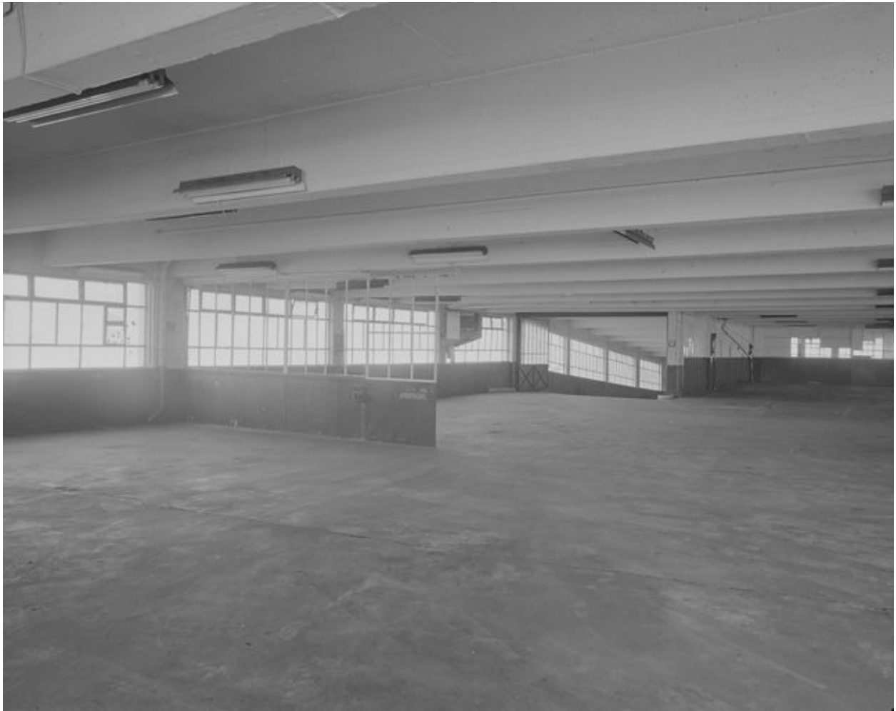
Vue d'ensemble du niveau 3.
