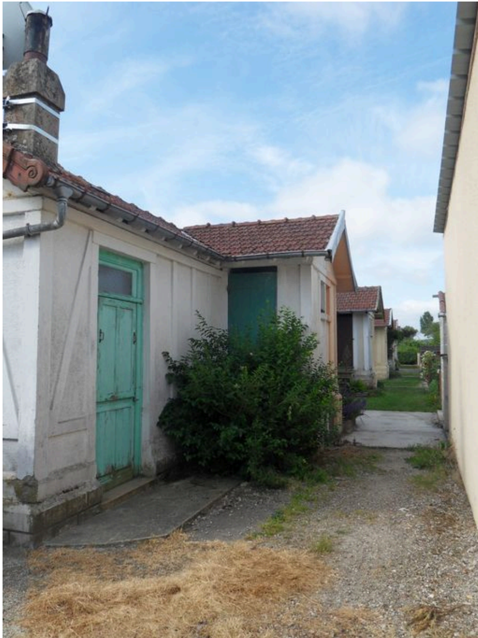
Dépendances des logements, rue Docteur-Jean-Martin prolongée (rive nord), dits cité des Italiens.
