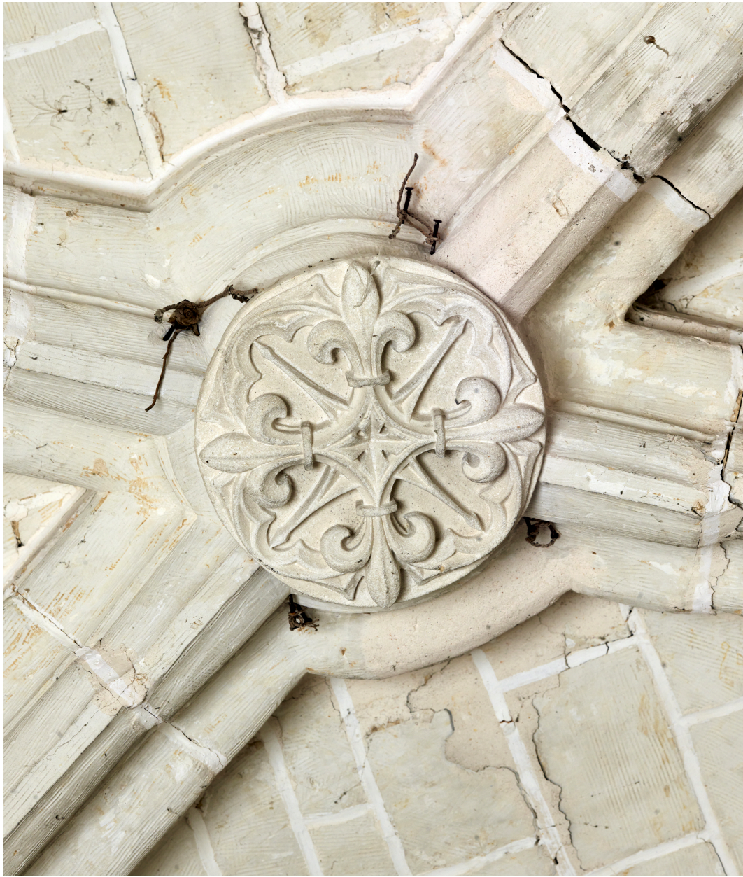
Intérieur, deuxième clé de voûte du chœur.
