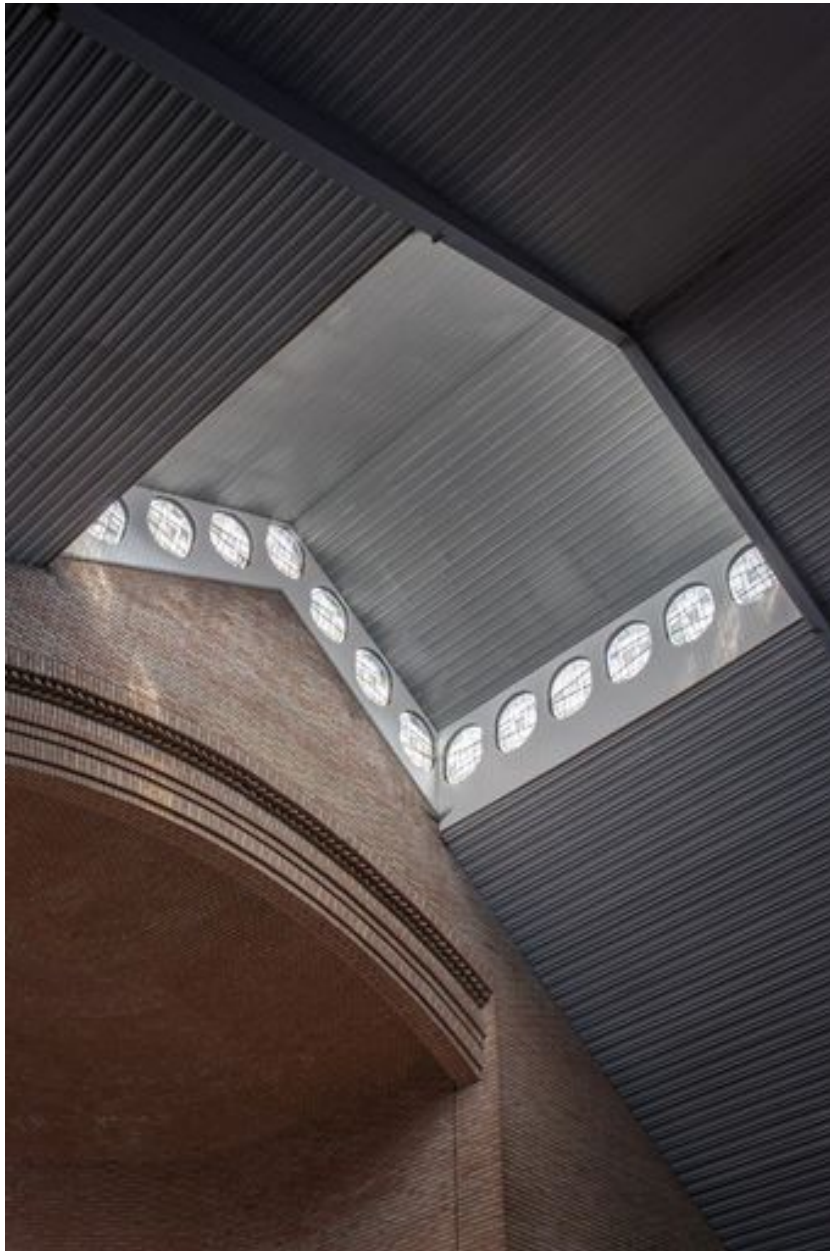
Vue de trois quart du lanterneau.
