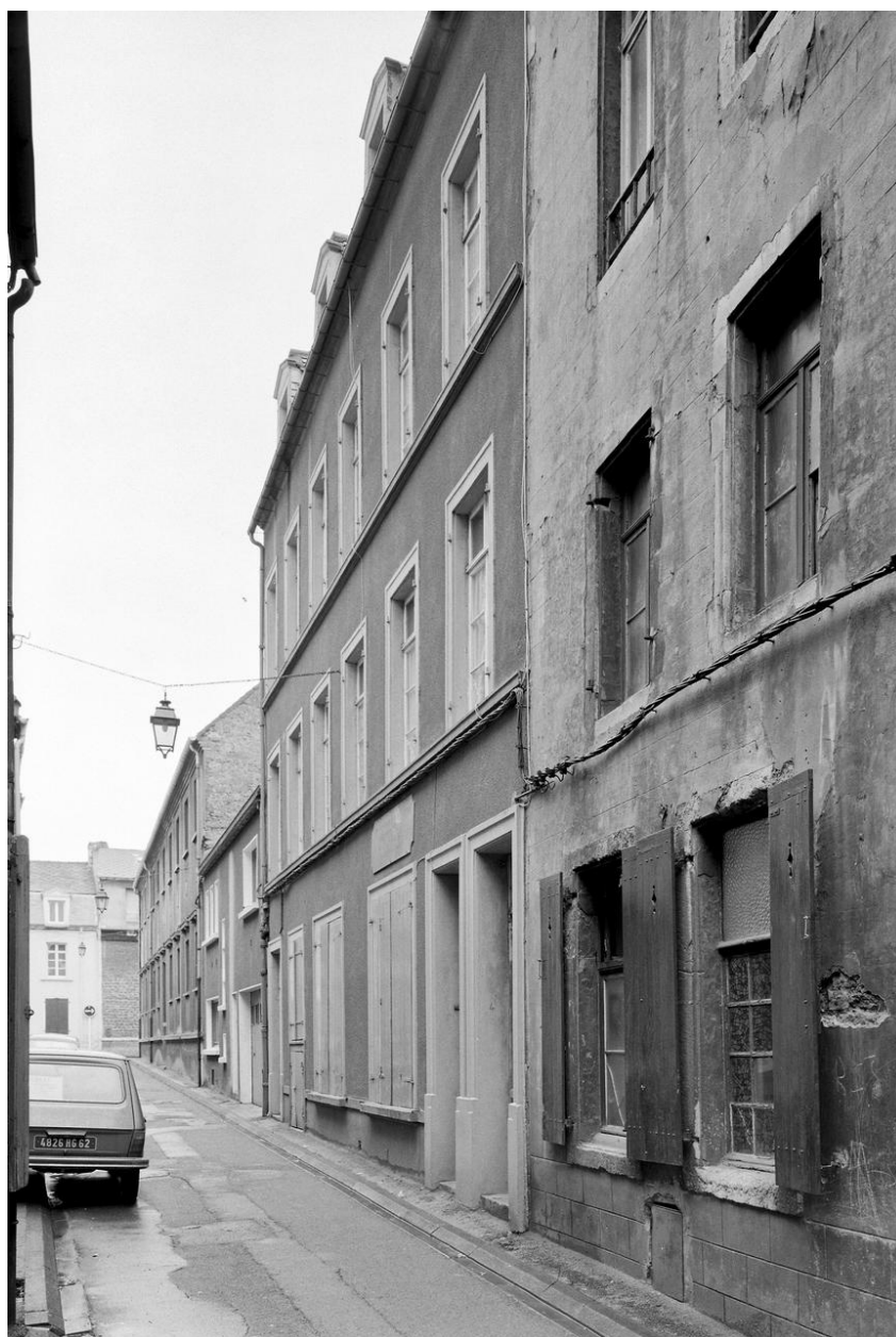
Vue générale sur voie.
