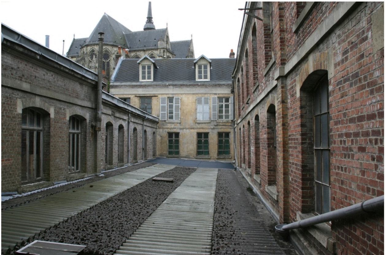
Façades sur cour.
