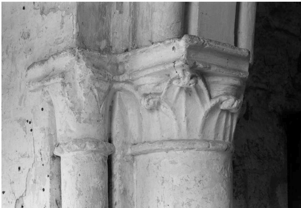
Bas-côté sud : détail d'un chapiteau.
