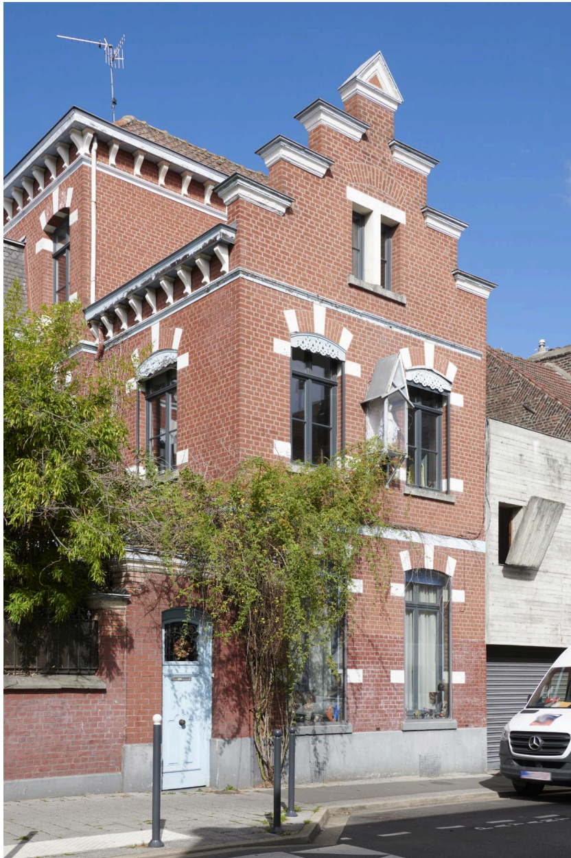
Détail de la façade rue du Trichon.
