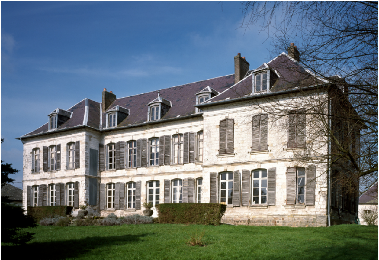
Elévation sud du corps de logis donnant sur le jardin.
