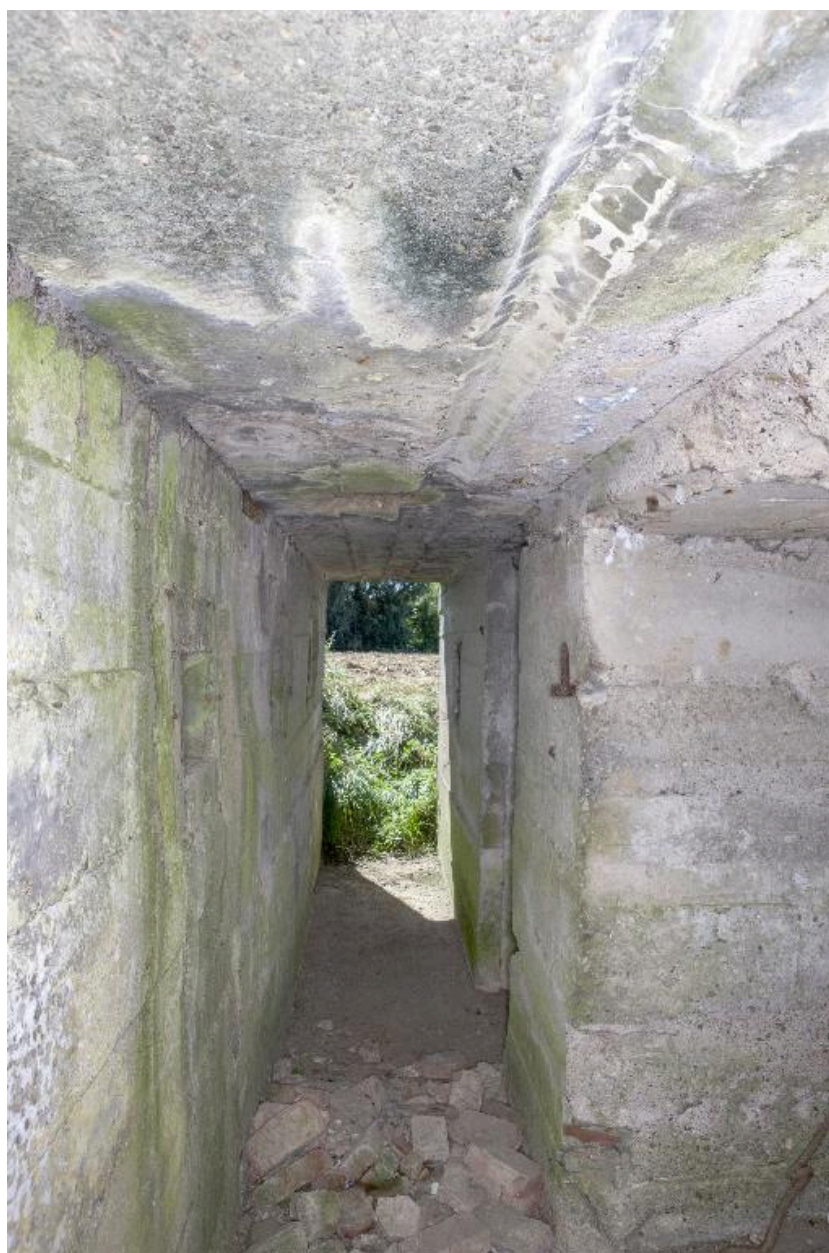
Intérieur du couloir de distribution, vers le sud-est
