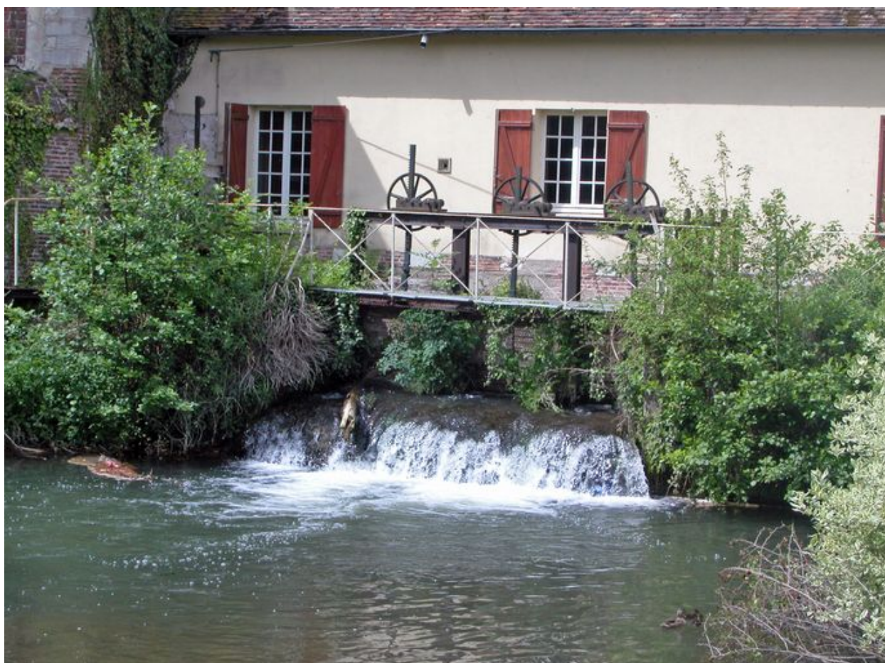
Détail du vannage et le bassin déversoir, côté ouest.
