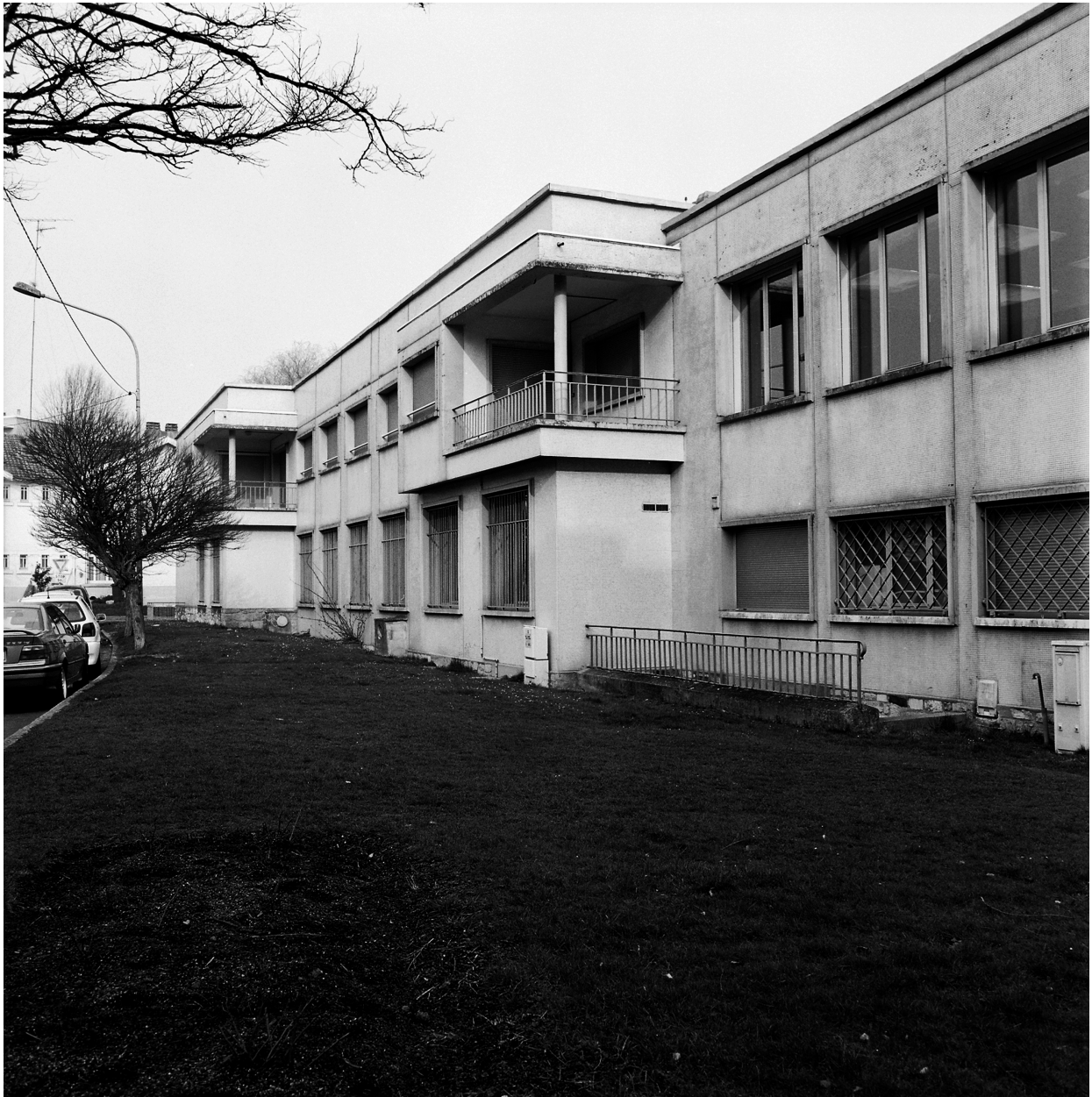
Vue générale de l'élévation postérieure (sud).
