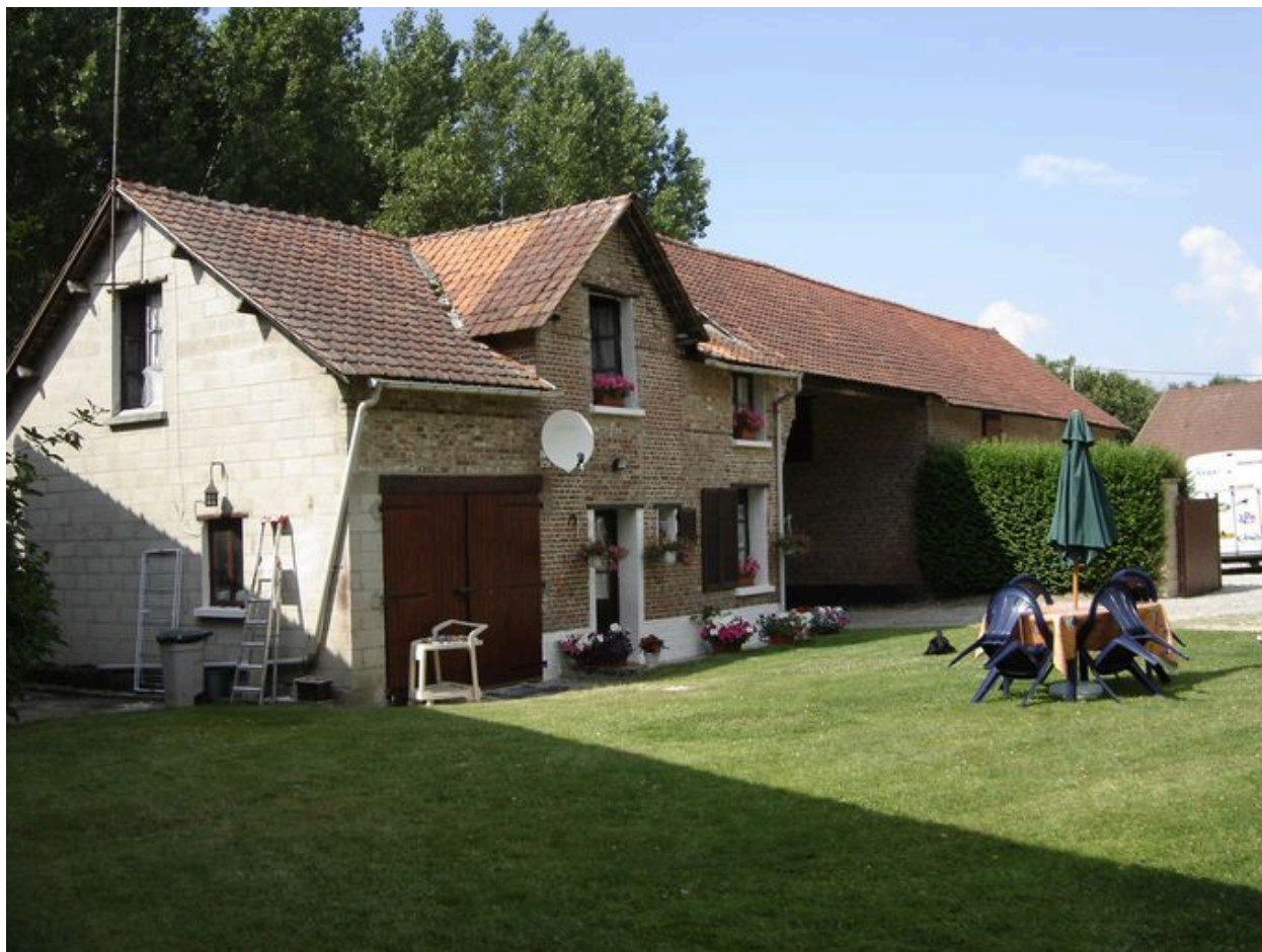
Vue des étables surmontées d'un fenil.
