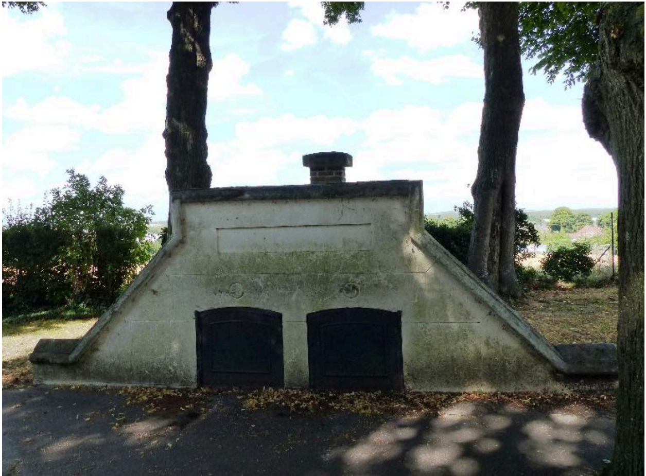
Le dépositoire. Vue de face.
