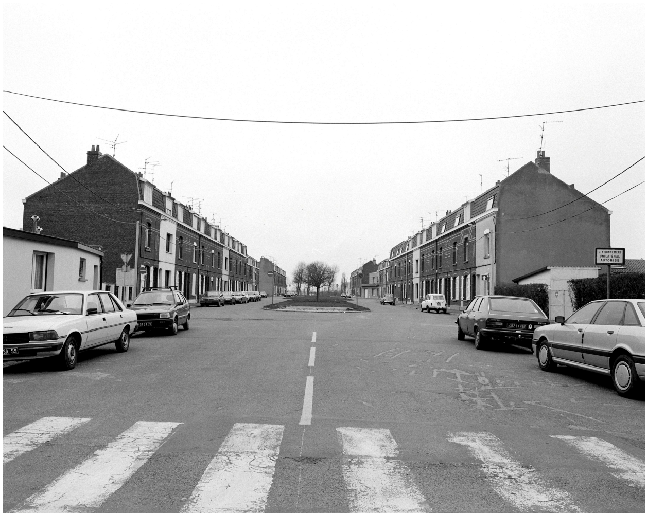
Cité ouvrière dite du Fort Mahieu.
