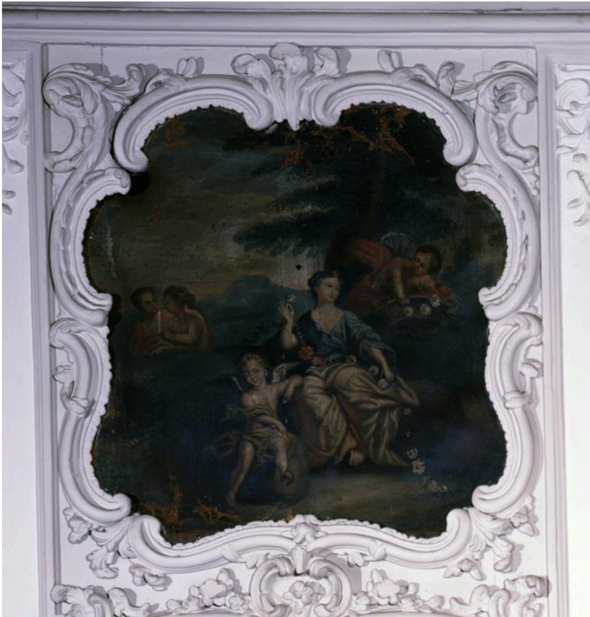
Vue de la partie supérieure du trumeau d'entre-fenêtre.
