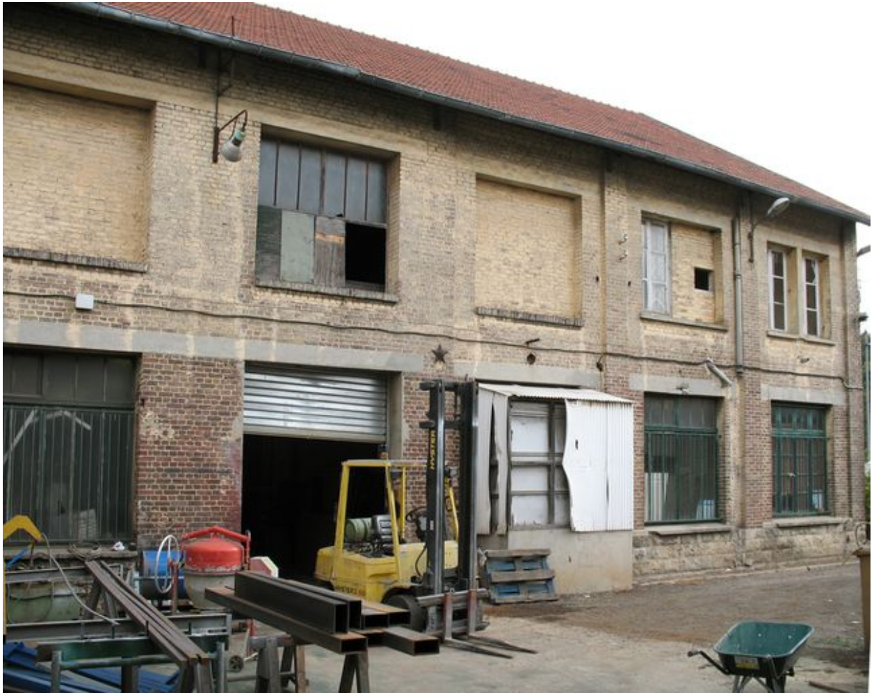
Façade ouest de l'ancien atelier des fûts d'emballage.
