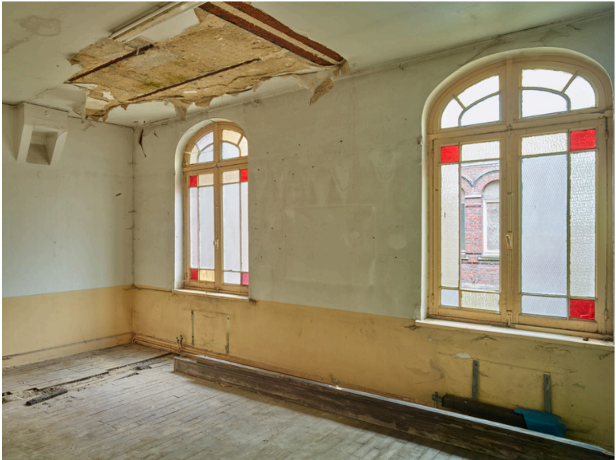
Bâtiment central, premier étage. Logement du directeur : vue du salon-salle à manger.
