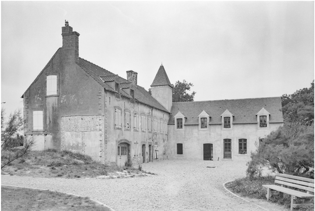
Vue générale de l'élévation postérieure et du bâtiment en retour d'équerre.
