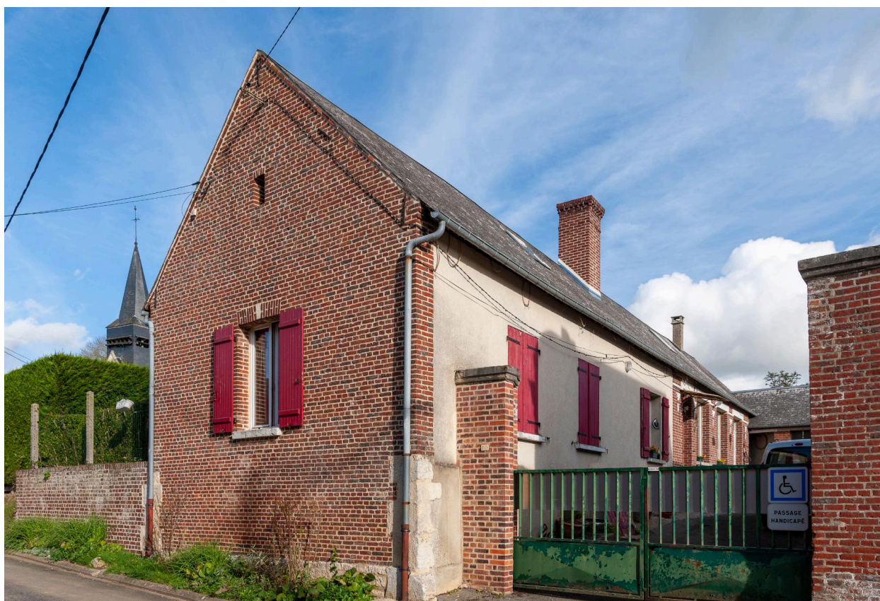
Ancienne école, vue depuis le sud-ouest.
