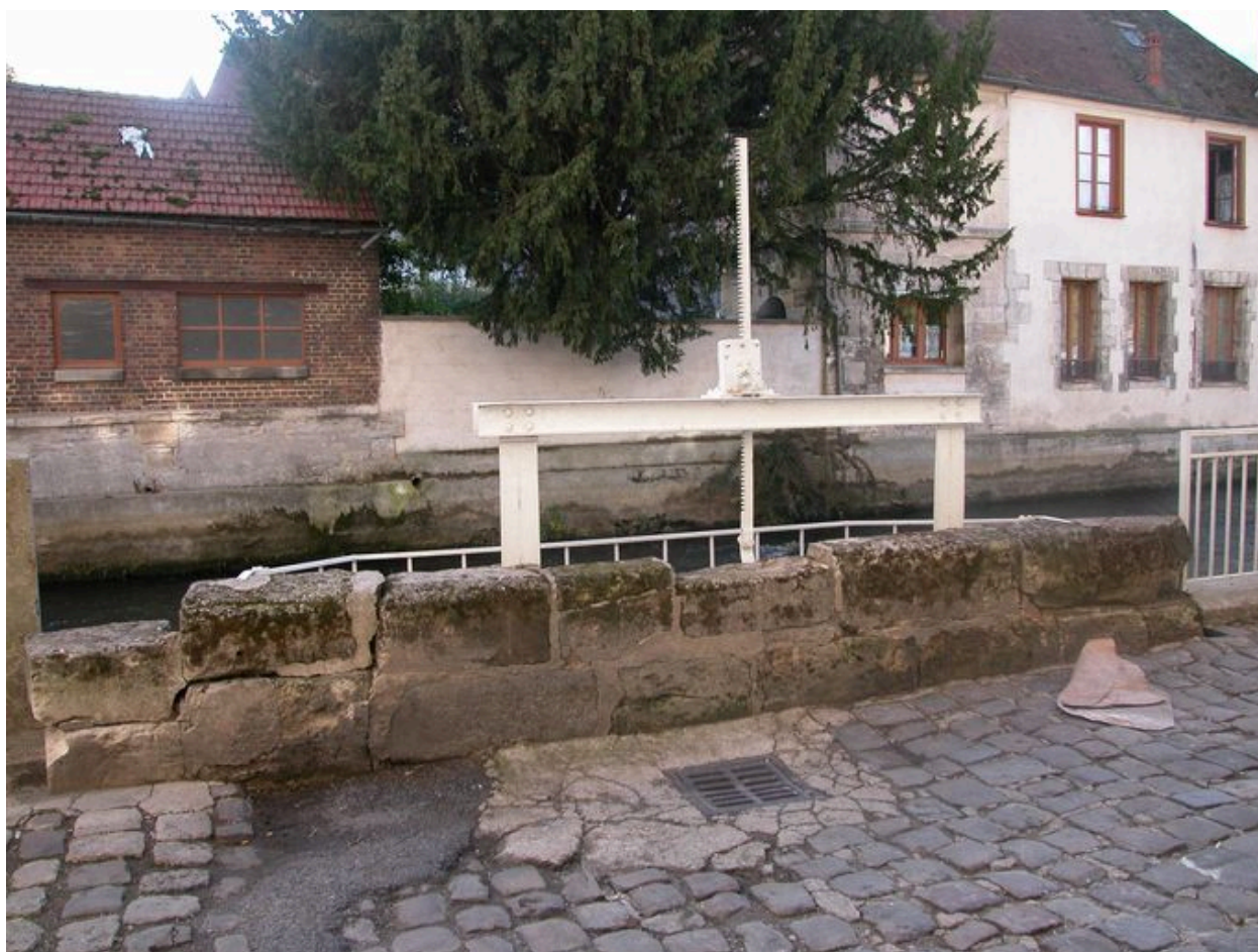
Vanne du canal de dérivation.
