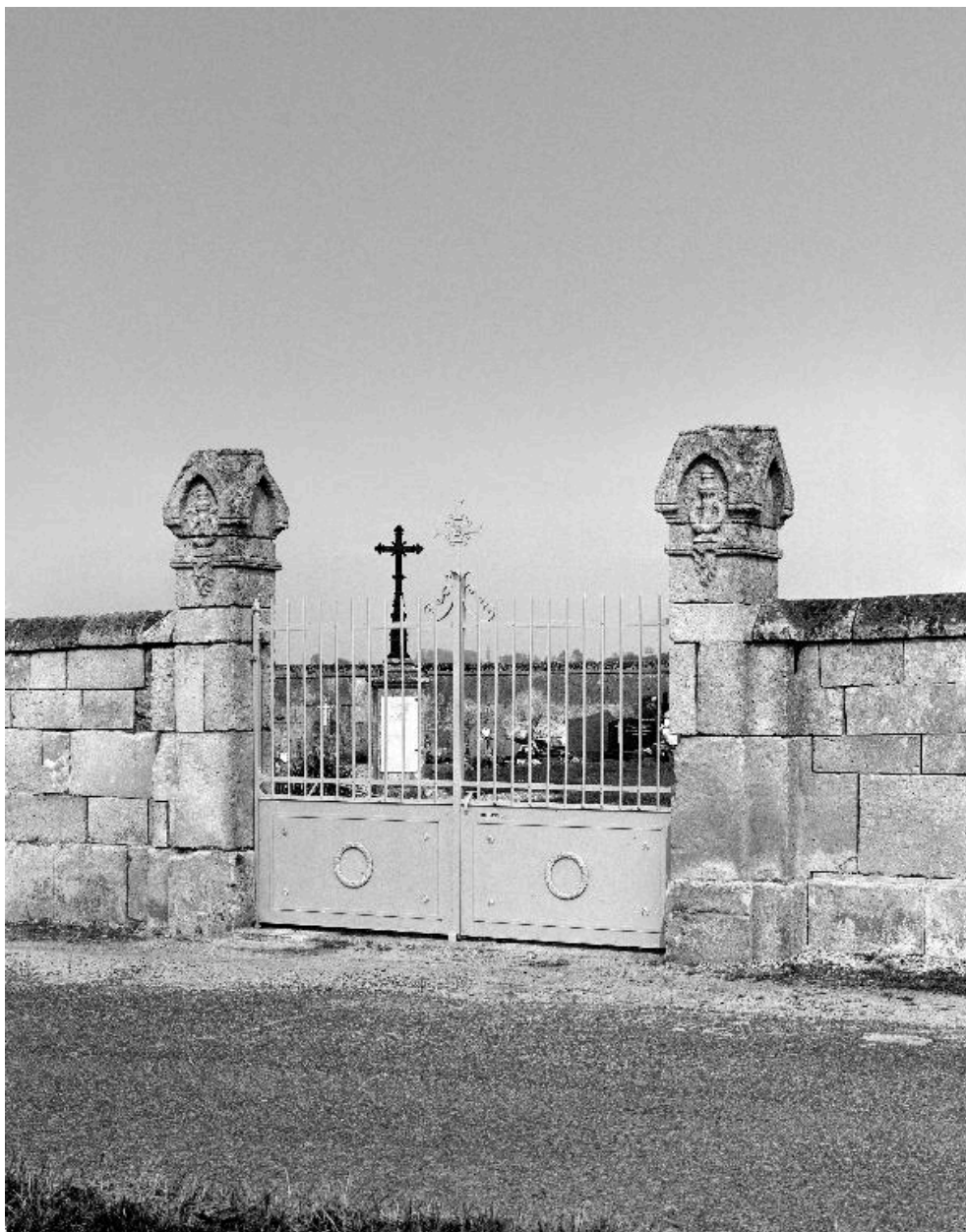
Vue de la porte d'accès.
