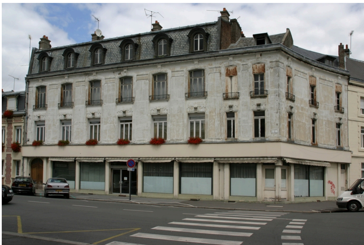
Façade antérieure, rue des Etats-Généraux.
