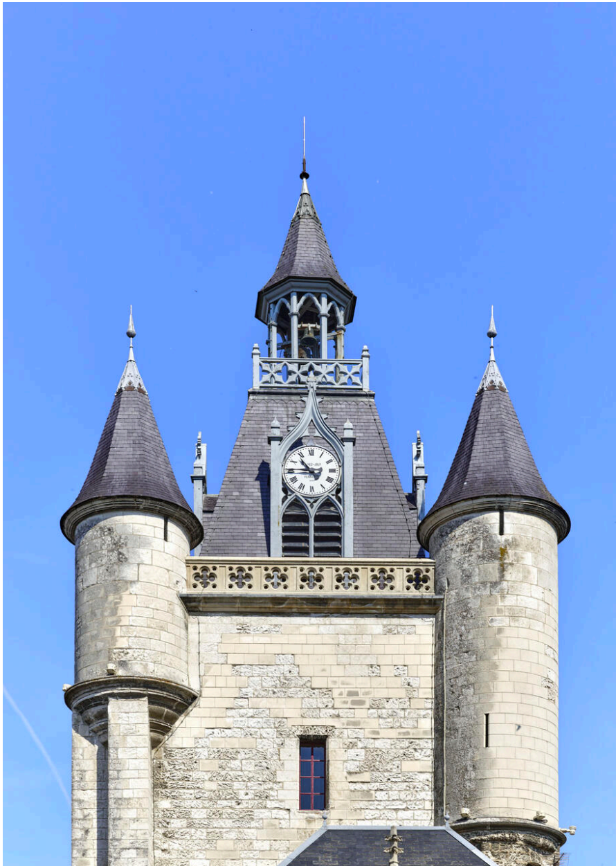
Détail de la couverture du beffroi et de ses tourelles.
