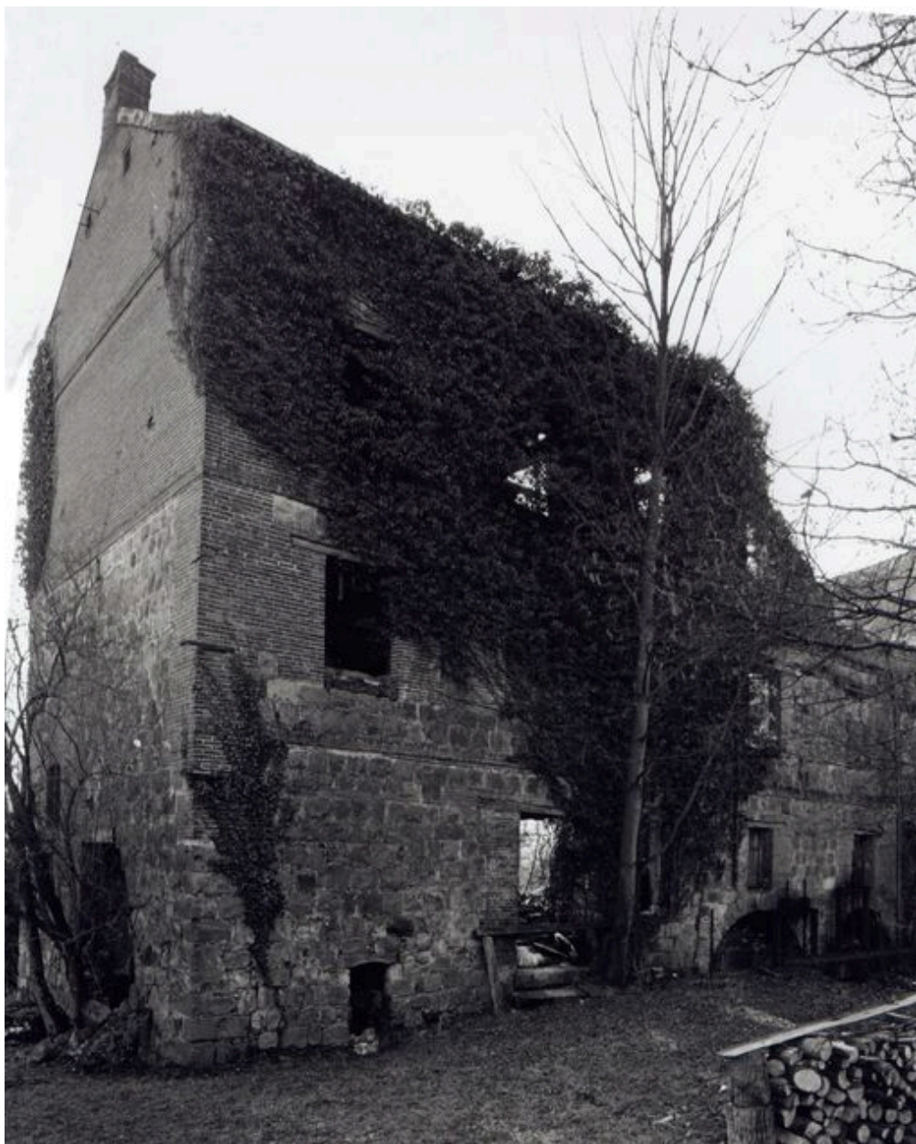
Elévation nord du moulin, vue d'ensemble.
