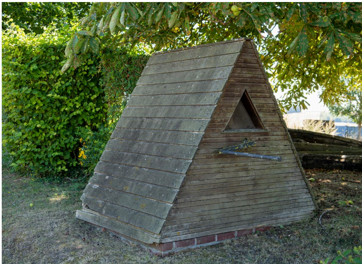
Puits au croisement de la rue du Plessier-sur-Bulles et de la rue de la Cense.
