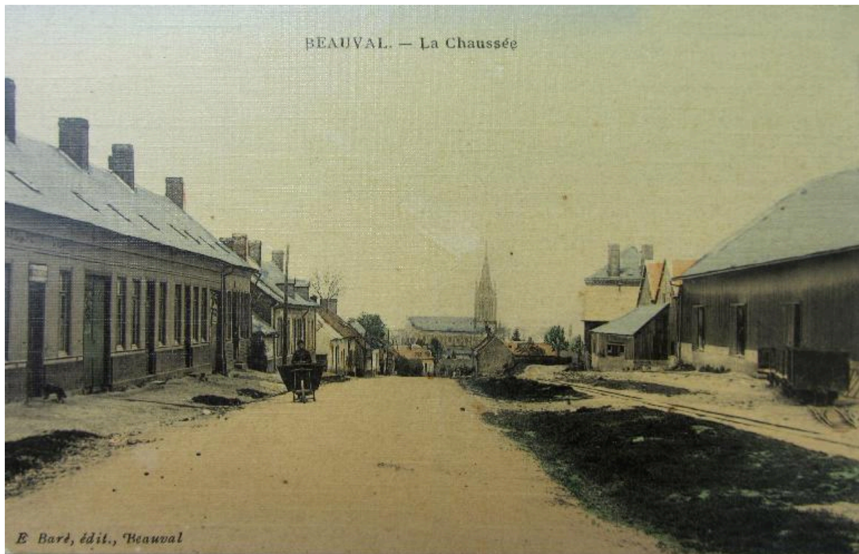
La route nationale avec les bâtiments de l'usine de phosphate et ses dessertes ferroviaires, début 20e siècle (coll. part.).
