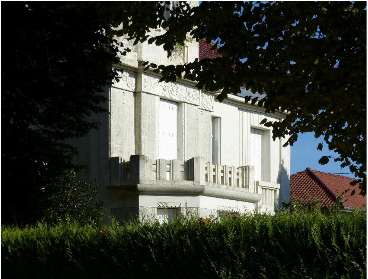
Vue de détail sur le décor Art-Déco de la façade sur rue.
