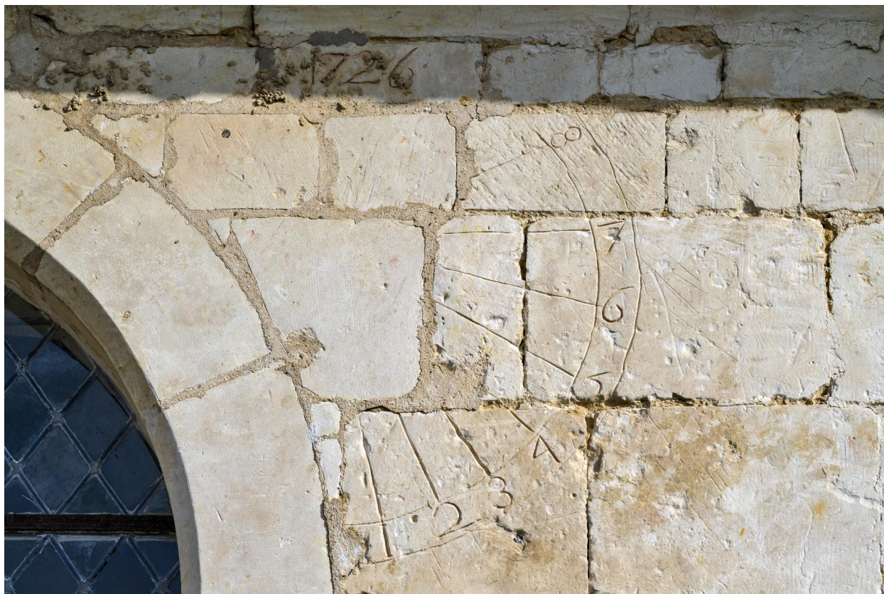
Cadran solaire et date portée : 1726. Élévation sud de la nef.
