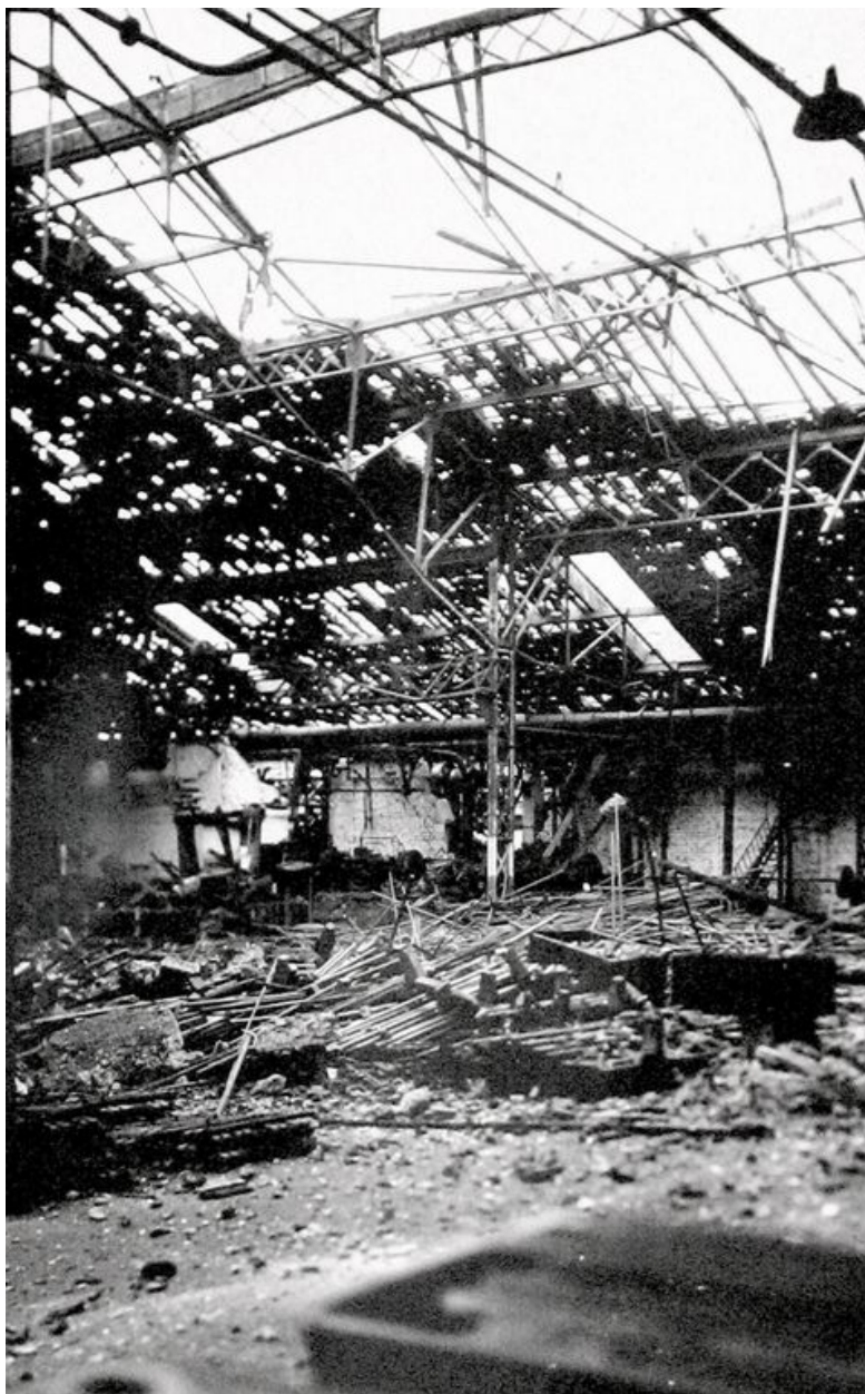
Atelier d'assemblage touché par les bombardements du 23 mars 1944 (AD Oise ; 753W28740).
