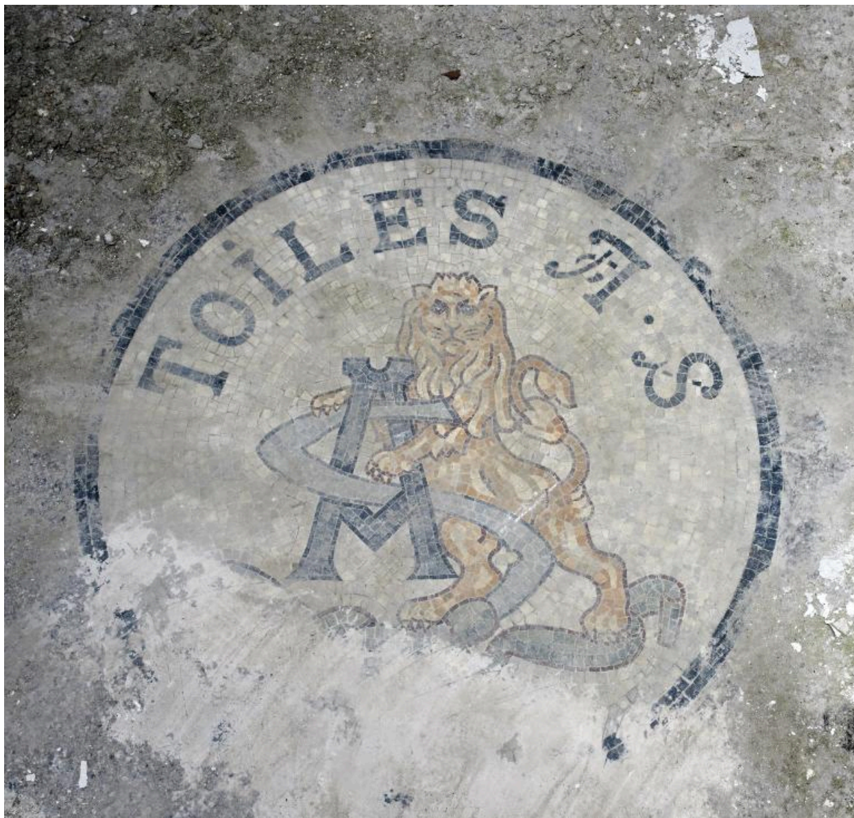
Bureaux, vue intérieure. Blason au sol en mosaïque, aux armes de l'entreprise.
