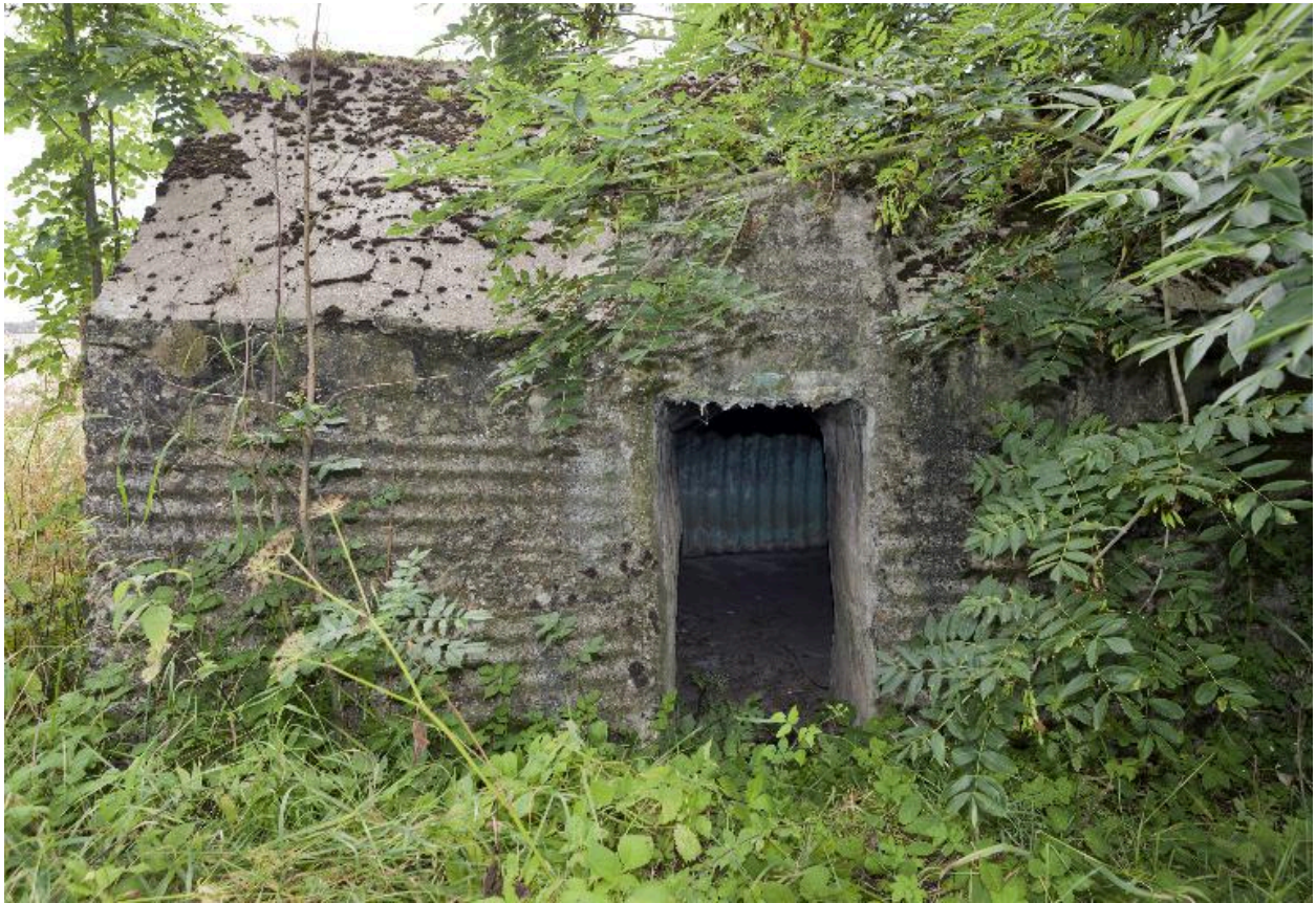
Entrée sur l'élévation nord-est, rue des Sûres
