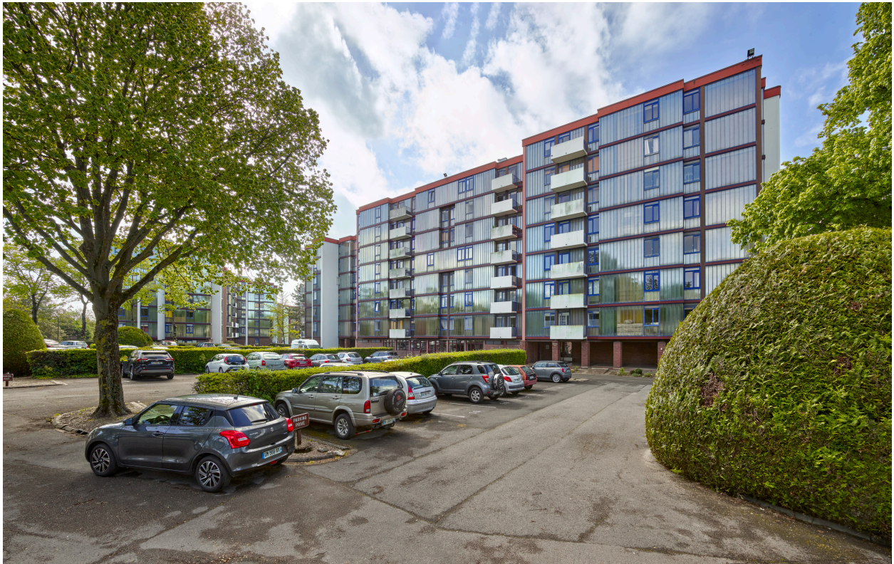
Vue du bâtiment F depuis le nord.
