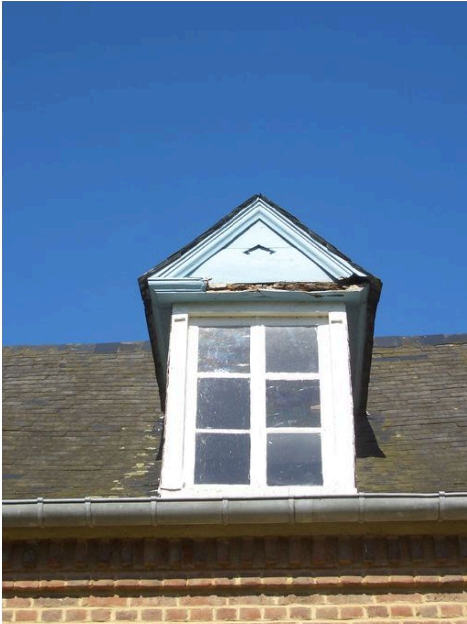
Vue détaillée d'une lucarne.
