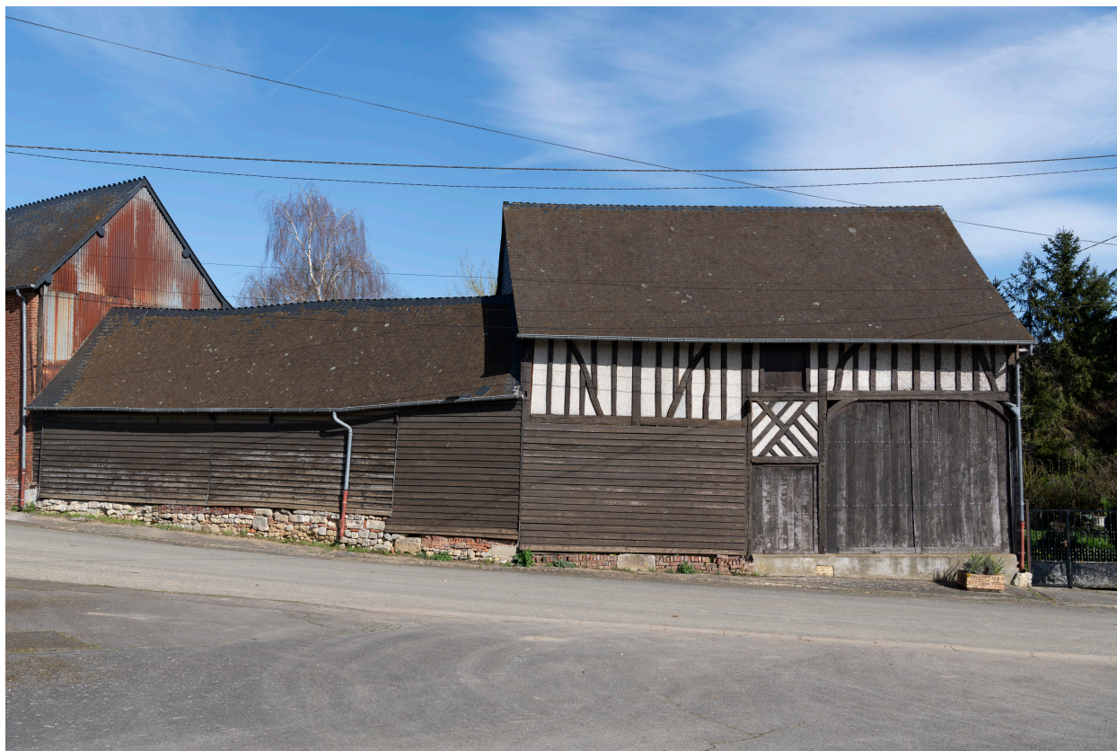
Grange et bâtiment agricole sur rue, n°22 de la rue Martin, vue prise depuis le sud.
