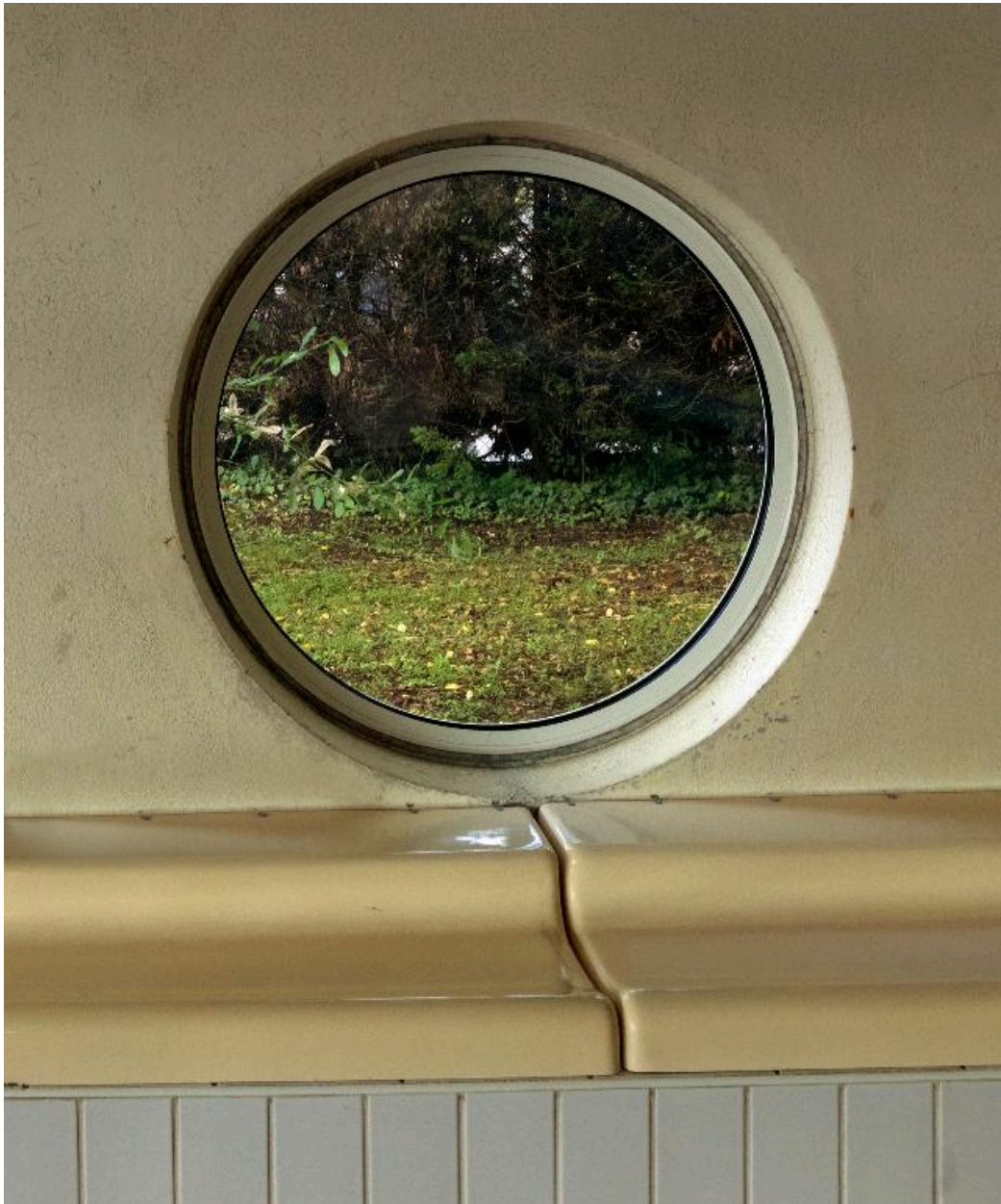
Détail d'une des ouvertures en forme de hublot.
