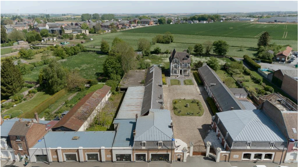
Vue aérienne de situation de l'ensemble des entrepôts, chais et villa depuis la rue du faubourg de Péronne.
