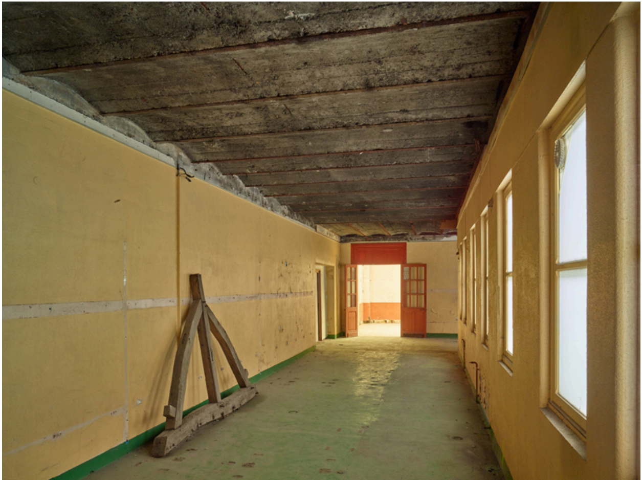
Aile nord, rez-de-chaussée. Vue de l'ancienne hydrothérapie des bains de baignoires de luxe pour dames, remaniée.
