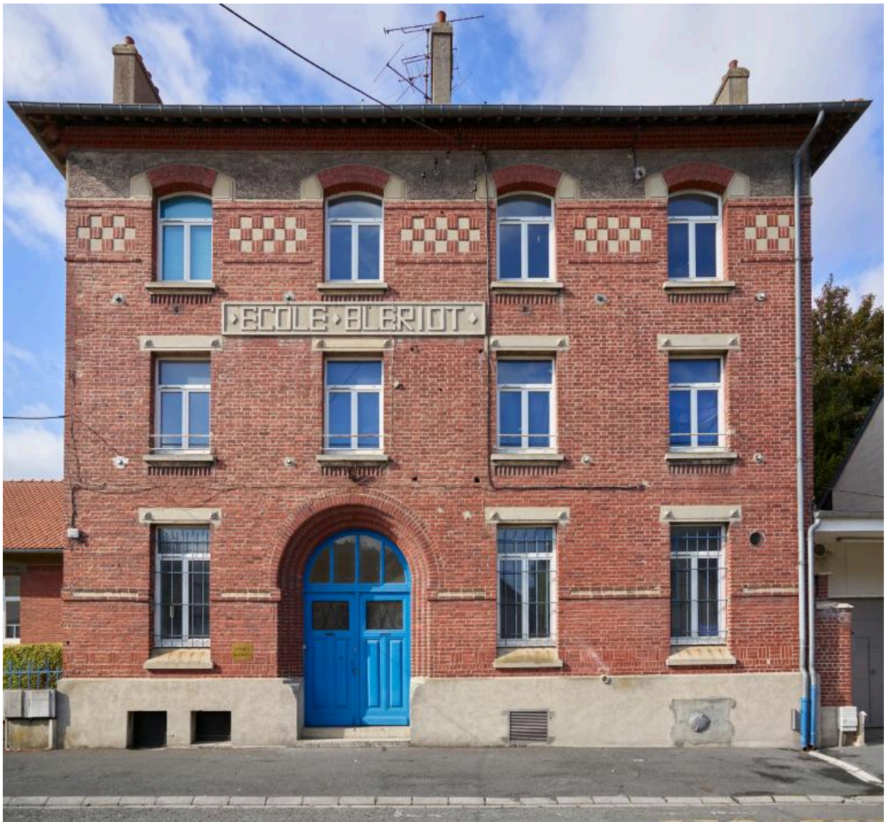
Vue du pavillon Blériot, façade sur le boulevard des écoles.
